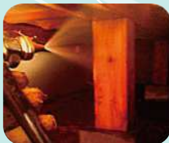
床下木部処理
